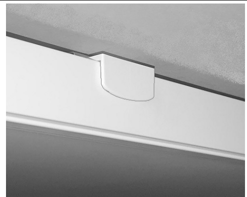
Figura 5. Clip correctamente instalado.
